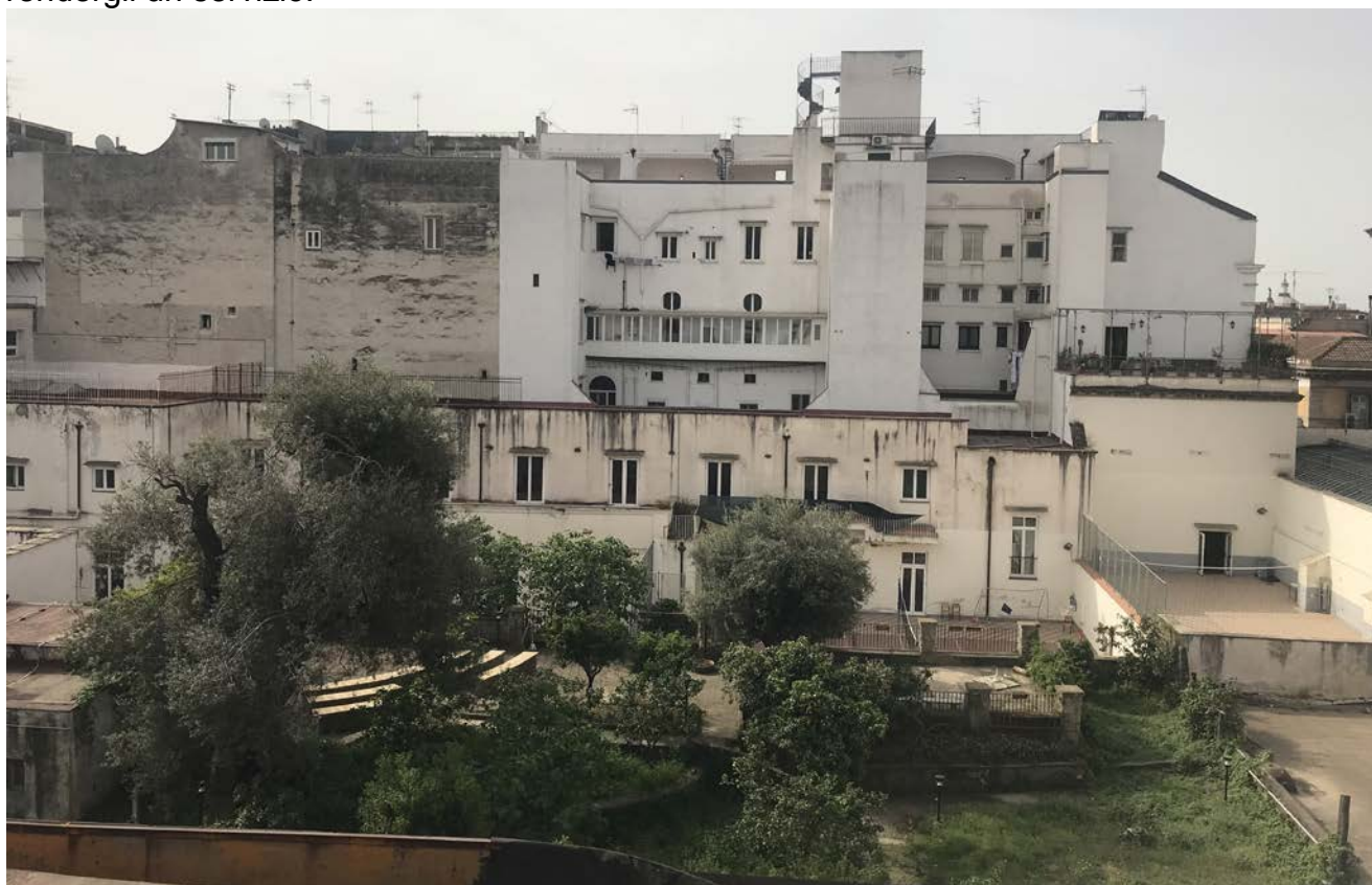
5: L'area del giardino di Costantinopoli con alle spalle l'imponente edificio per abitazioni ottocentesco. Aprile 2018, vista dalle coperture della navata della chiesa.
