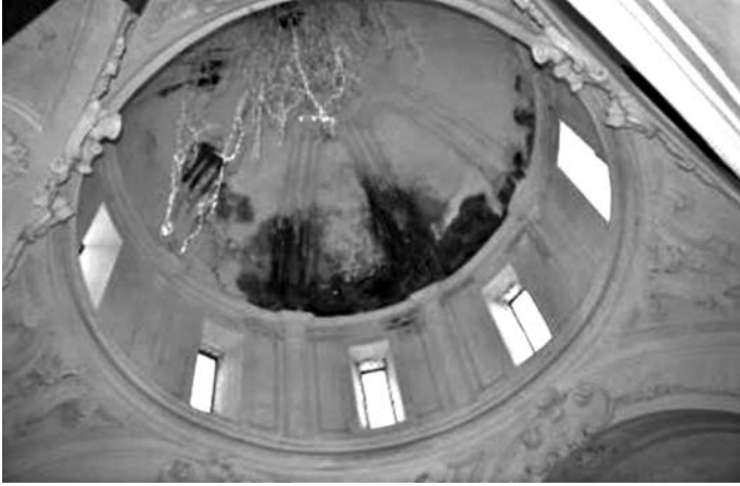
Nocera Inferiore (Salerno), convento di Sant'Andrea. Vista dell'intradosso della cupola della cappella Carafa, fatta edificare a partire dal 1563 dal duca Alfonso Carafa, qui anche sepolto
